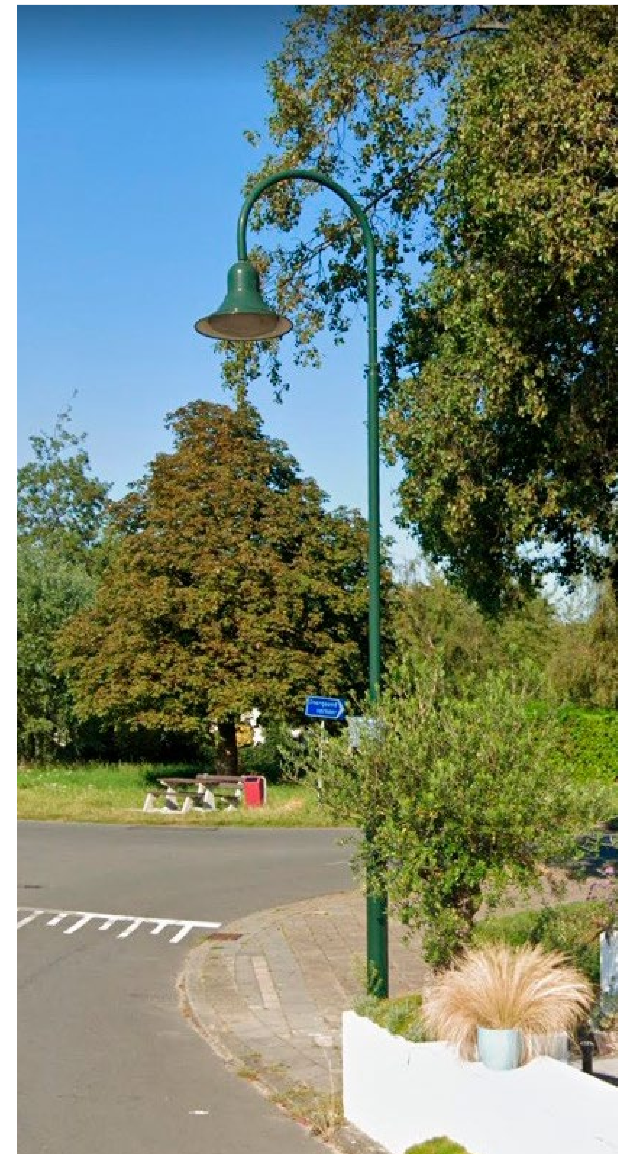
Type lichtmasten en armaturen.
