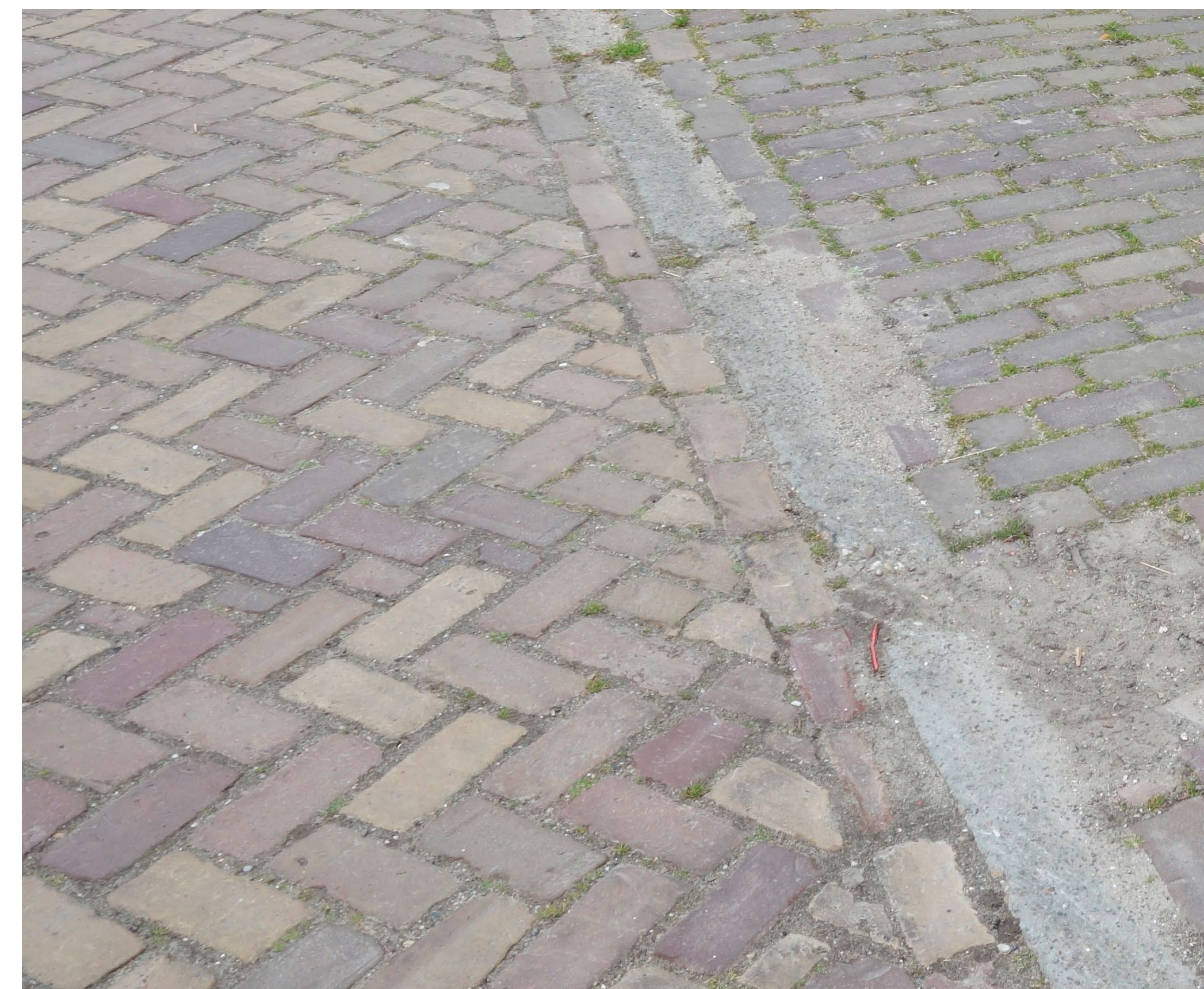
Rijbaan en parkeervak in klinkers, geen hoogteverschil tussen rijbaan, parkeervak en trottoir.
