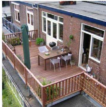
Materiaal, massa en kleur sluit aan bij bestaand
