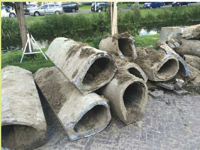
Vervangen van riolering aan de Allard Piersonkade 2015.
