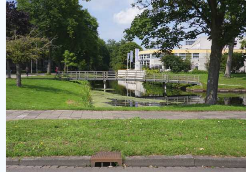
Figuur 3-1: Meer ruimte voor water: een brug in plaats van een duiker
