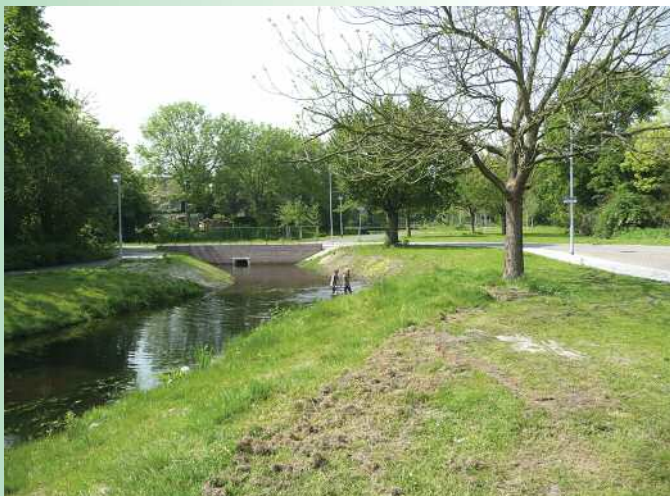
2012 duiker verwijderd en watergang aangelegd.
