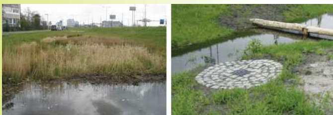
Figuur 3-4: Een wadi met overstort nabij de Westvlietweg
