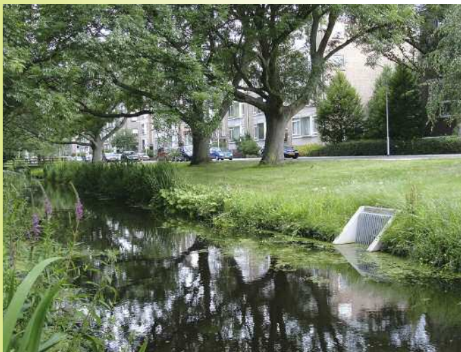
Hemelwater voert af naar de Machinesloot aan de Aart van der Leeuwkade, een directe relatie tussen riolering en water.
