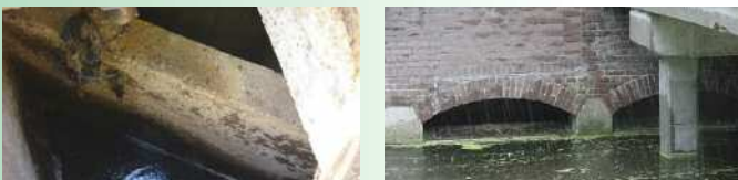
Figuur 22: Overstorten: links als een schuine muur in een rioolput, rechts als muur met opening naar een watergang.
