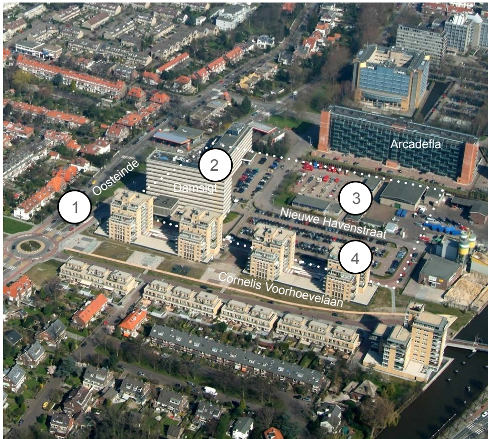
Luchtfoto deellocatie, panden op het voormalig Mebin- en Avalexterrein inmiddels gesloopt
