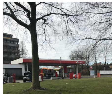
1. Huidig Total pompstation
