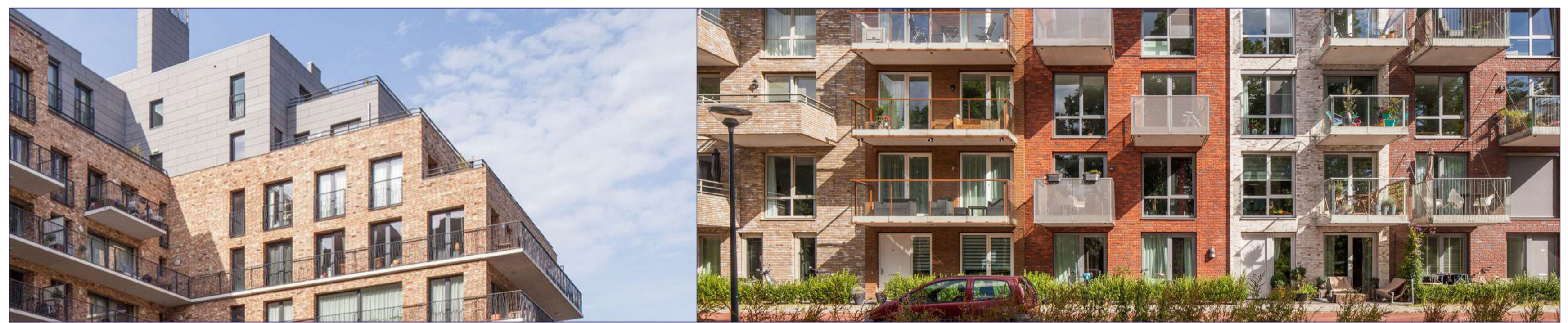
panden en enkele hoogteaccenten Etalage
